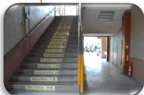
6 號樓梯-校園安全死角
